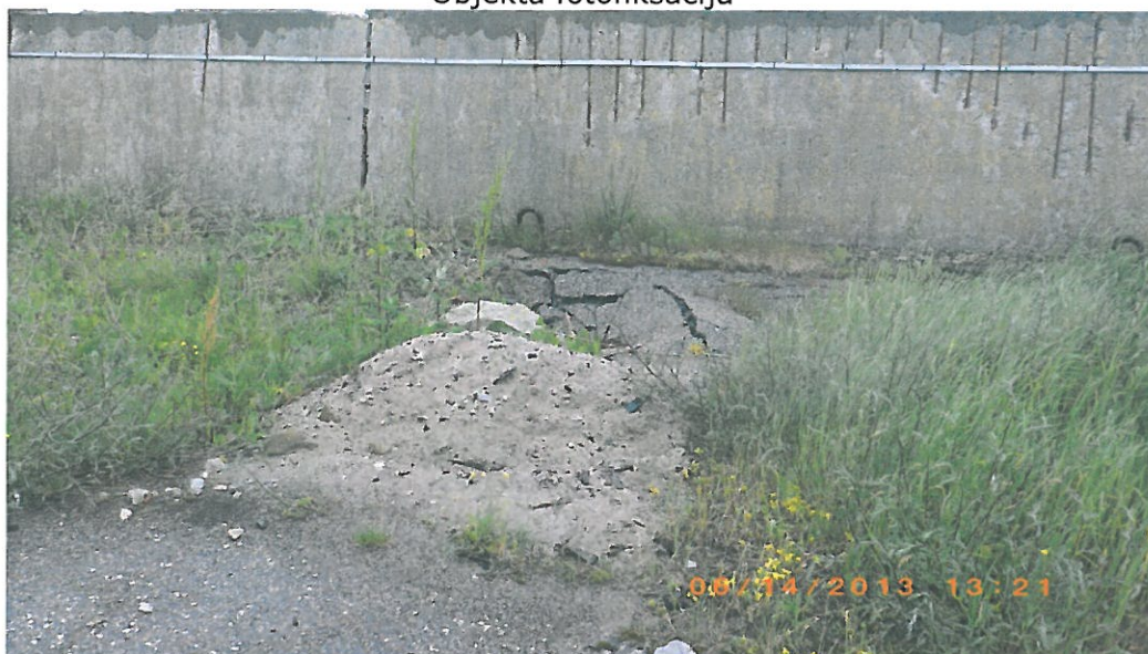
1.att. Iesēdumi teritorijas segumā. Parapeta sienas bojājumi.
